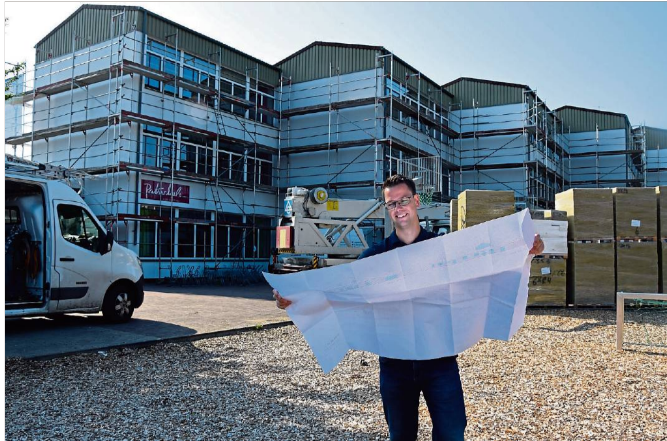
An der Ratsschule haben die Handwerker das Sagen. Michael Schönwald vom Gebäudemanagement informiert über den Stand der umfangreichen Bauarbeiten, die während der Sommerferien laufen. Foto: Simone Grawe
